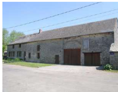
Ancienne ferme élémentaire à Hestrud.
