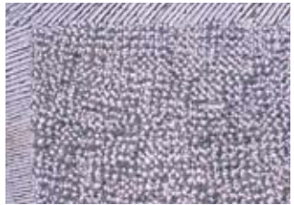
Pierre de remplacement layée et bouchardée
