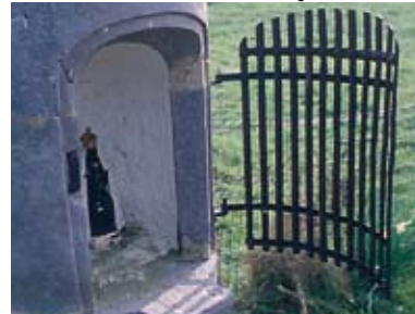
Détail montrant la niche, son contenu et sa grille de fermeture
