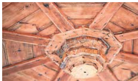
Charpente du kiosque - Sars Poteries
