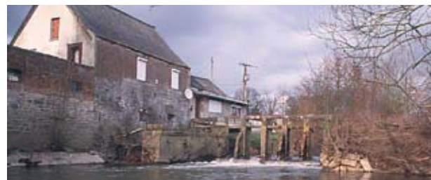
Ventelles attachées à l'ancien moulin de Boulogne sur Helpe : lecture des éléments manquants
