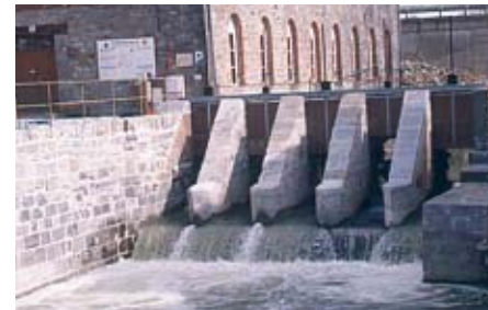
Restauration des ventelleries d'Etœungt
