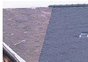
Restauration en ardoises de teinte foncée d'un toit initialement de teinte rosée
