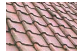
Toiture en tuiles anciennes de terre cuite
