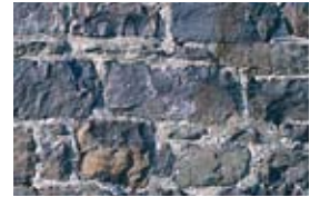
Maçonnerie de moellons de pierres
