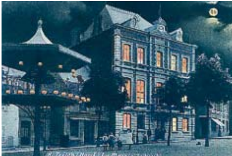
Kiosque à danser - Trélon
