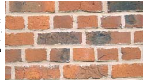
Joints débordants de ton trop clair annihilant la qualité de cette maçonnerie de brique
