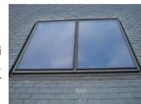
Panneau solaire thermique intégré à la toiture
